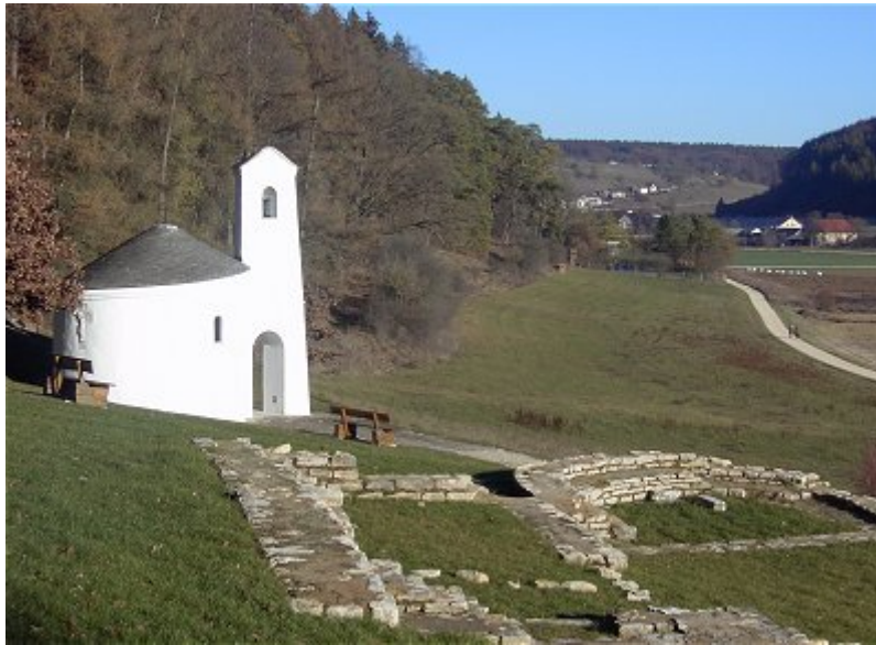
Die Fundamente der mittelalterlichen und die neue Gunthildiskapelle im oberen Schambachtal
