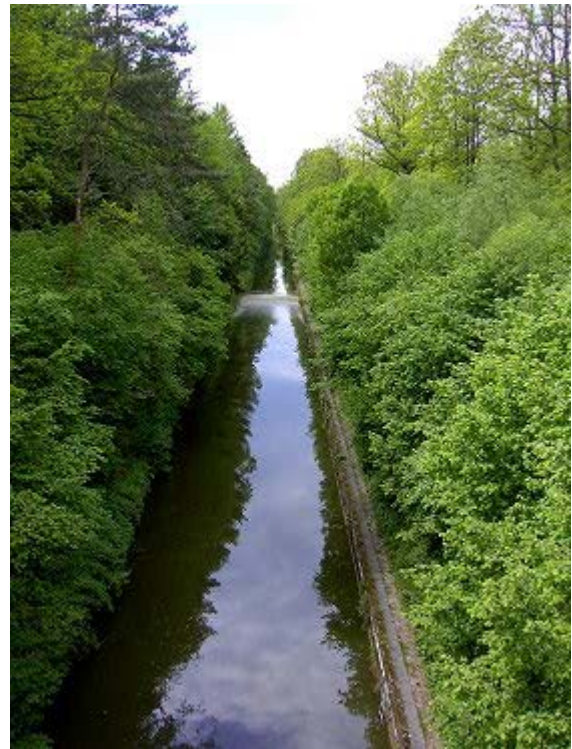
15 m tief ist der 879 m lange Dörlbacher Einschnitt
