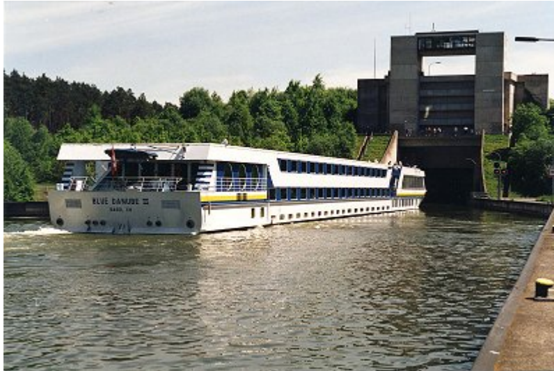
Schleuse Eckersmühlen mit Hotelschiff
