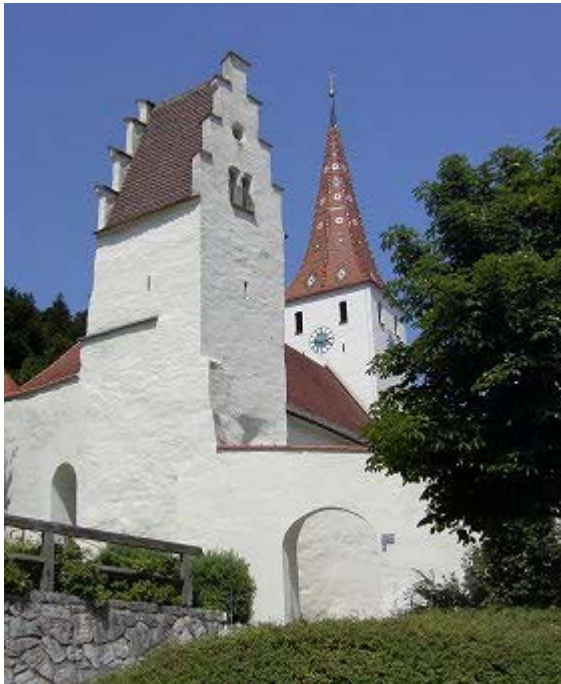
Wehrturm des Wehfriedhofs in Kinding
