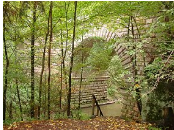
Kanalbrücke (Brückkanal) bei Feucht
